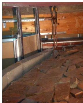
Couche isolante en briques récupérées d'un ancien four à pain
