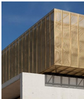
Centre éducatif et culturel de Pau : résille extérieure en alliage de cuivre © David Helman
