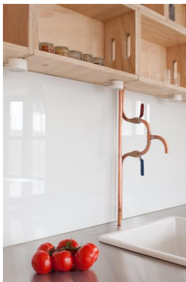
Robinet et canalisations en cuivre apparents Cobble Hill Studio – Coadaptative, Brooklyn © Peter Dressel
