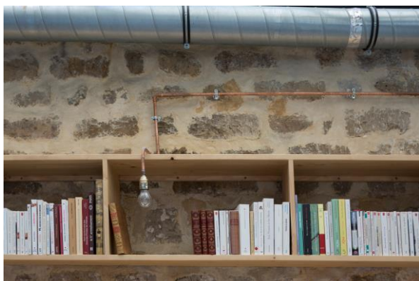
Les tubes de cuivre cachent les fils électriques Loft MDP – Maxime Jansens – Paris, 10 e © Cécile Septet
